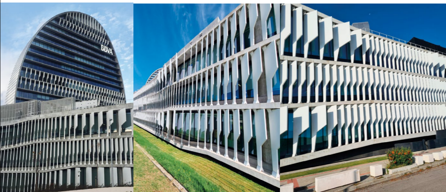
Edificio BBVA, Madrid, por JACQUES HERZOG y PIERRE DE MEURON
